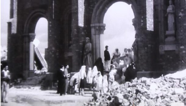
廃墟と化した天主堂 (1945 年 11 月)
